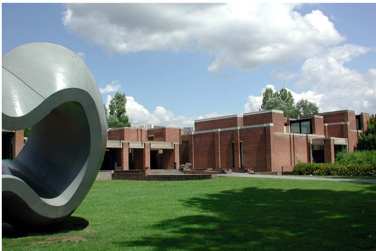
Vue du LaM, Villeneuve d'Ascq. Bâtiment construit par Roland Simounet. Au premier plan : Richard Deacon, Between Fiction and Fact , 1992. Photo : DR. © Richard Deacon
